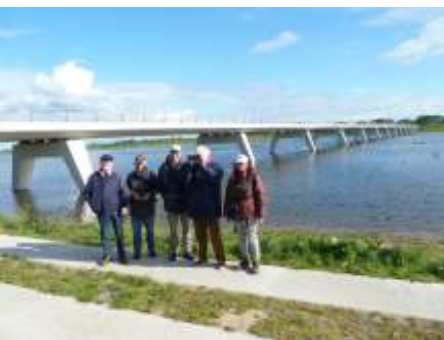
De nieuwe brug over het Reevediep in 2019, foto Hans Fondse
