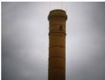
De schoorsteen van de steenfabriek, foto Hans Fondse
